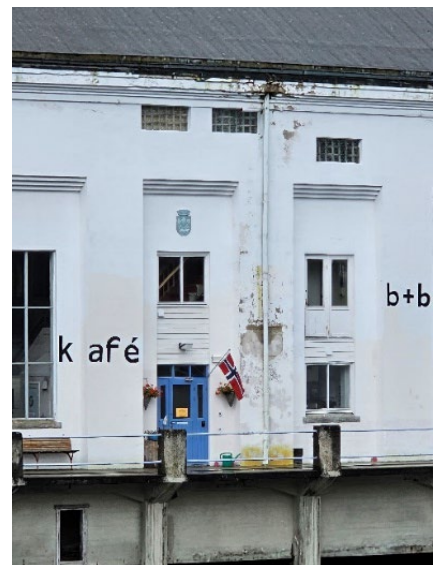
Fasaden på kraftstasjonen forvitrer litt hver vinter
