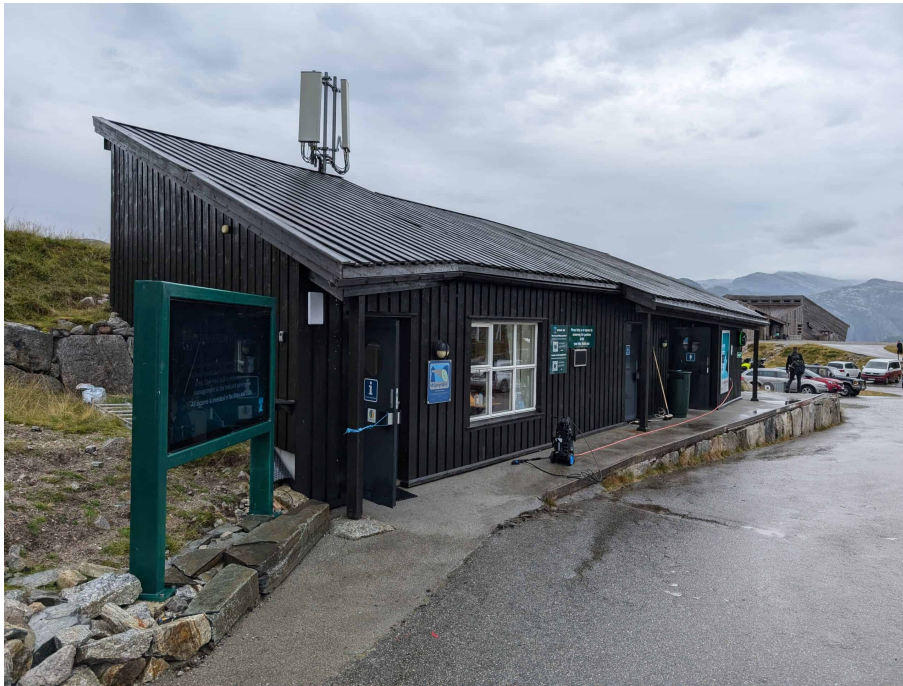
Figur 10 Servicebygget med turistinformasjon, toaletter, brukerundersøkelse, og digital informasjonsskjem.
