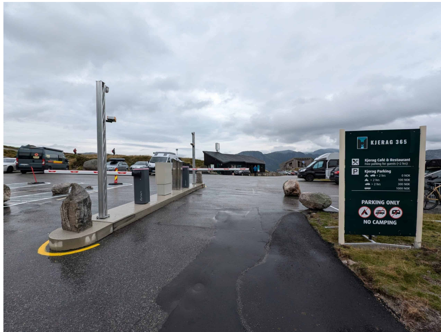
Figur 9 Inngang med nytt bomanlegg
