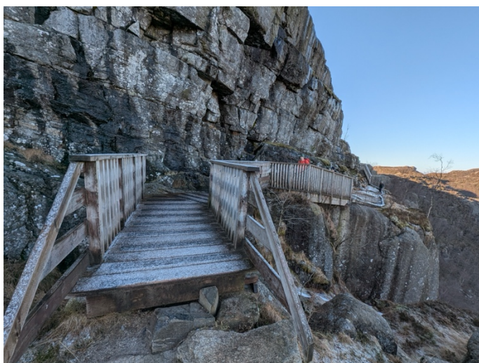
Figur 70 | 2001 omkom en svensk kvinne etter å ha falt fra stien i forkant av Preikestolen. Broene som er blitt bygget ut trinnvis langs stupet har fungert som et veldig godt sikringstiltak.
