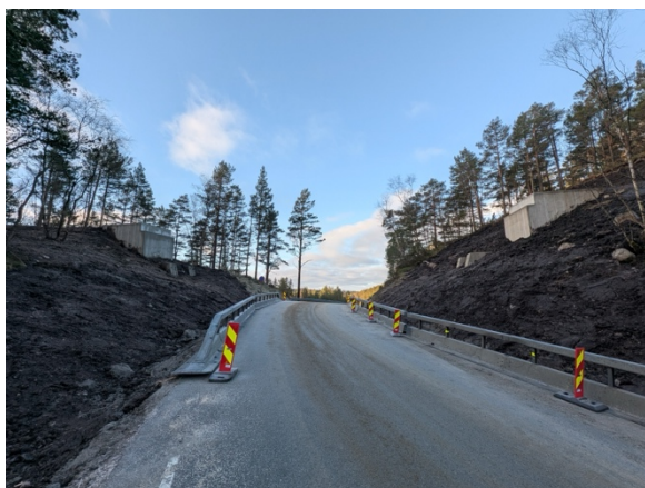
Figur 21 og 22 : Betongfundamentene til broen står klare.
