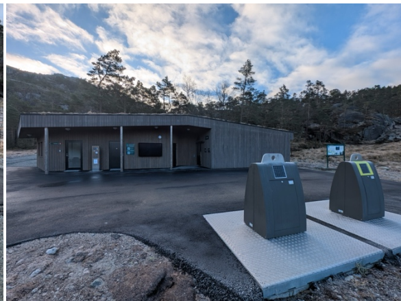
Figur 18 Toalett- og servicebygget på Moslimyrå Parkering
