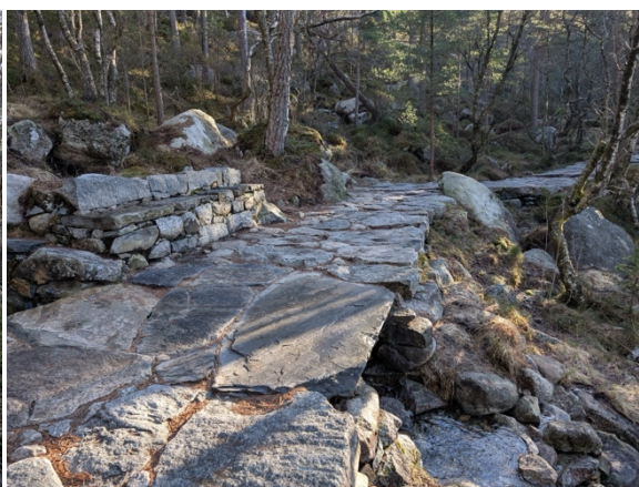
Figur 46 Ny steinlegging (2024) mot Urskar
