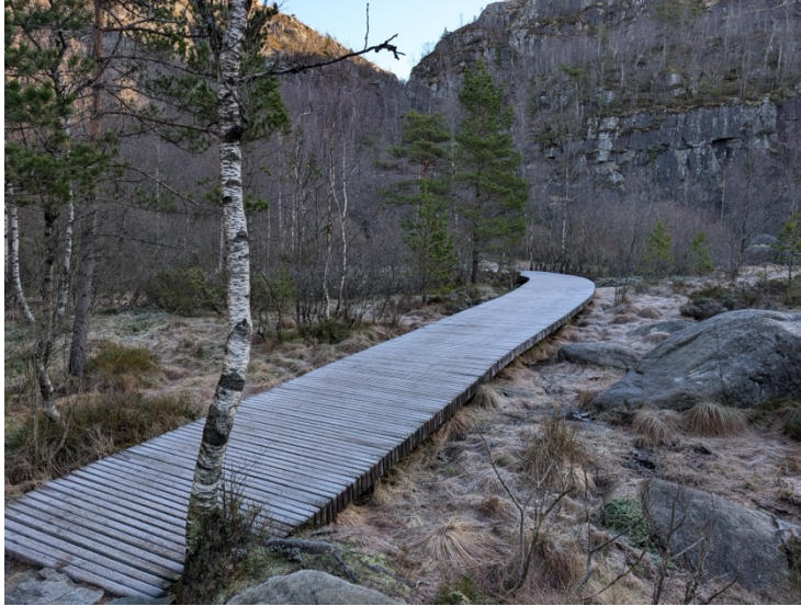
Figur 55 Gangbaner i bunnen av Neverdalsskaret
